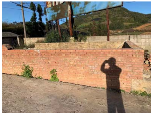
生活垃圾收集池
