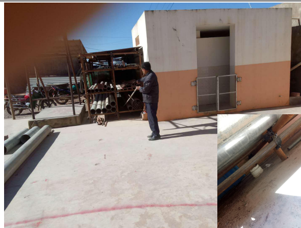
二采区水冲厕（吸粪口）
