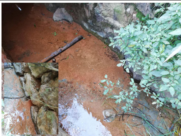
雨水收集沟渠
